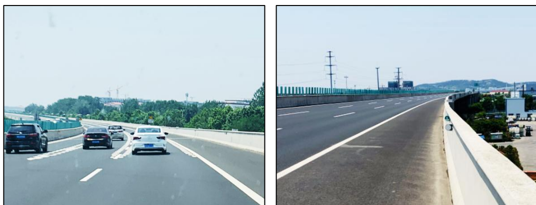
图 5-2 城阳高架桥路段
