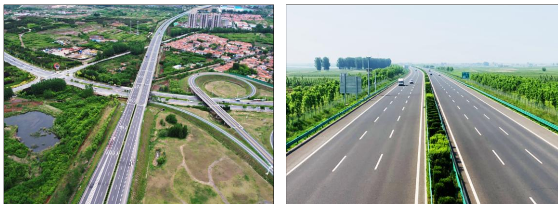
图 3-2 龙青高速公路（青岛段）主线
